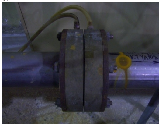
Σχήμα 2. Επιμέρους διατάξεις του κλειστού αγωγού. α) Ο αγωγός Ventouri, β) η στροφή 180°.0 και γ) το διάφραγμα
