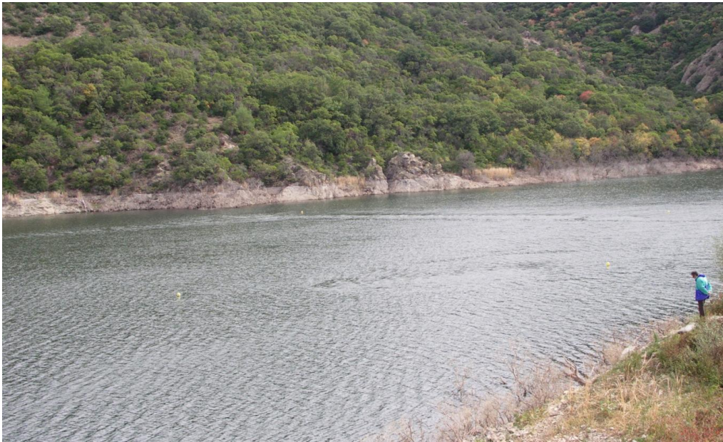
Σχήμα 4. Ίχθος ανάδευσης εξαιτίας της διάχυσης αέρα από τους αγωγούς Β και C.
