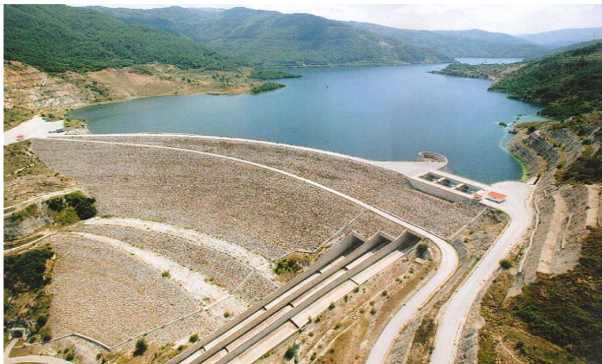
Σχήμα 2. Υδροηλεκτρικό έργο Θησαυρού (ΔΕΗ)
